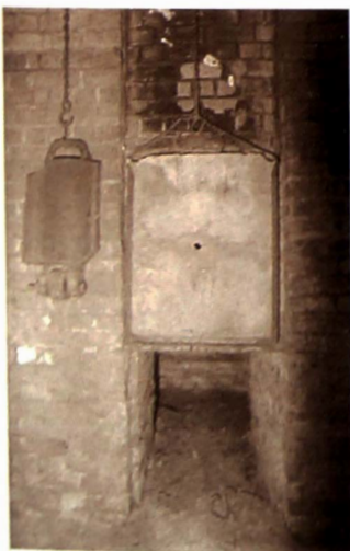
Afb. 54: De afsluiting van de oveningang met metalen valdeur en tegengewicht. De breedte was juist gepast voor een kruiwagen (foto: Davy Breyne, 1997).
