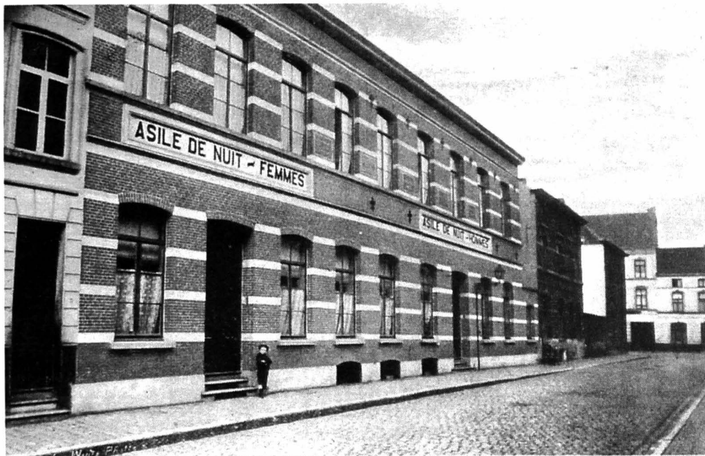
Afb. 1. Het gebouw in de Tinkstraat.
