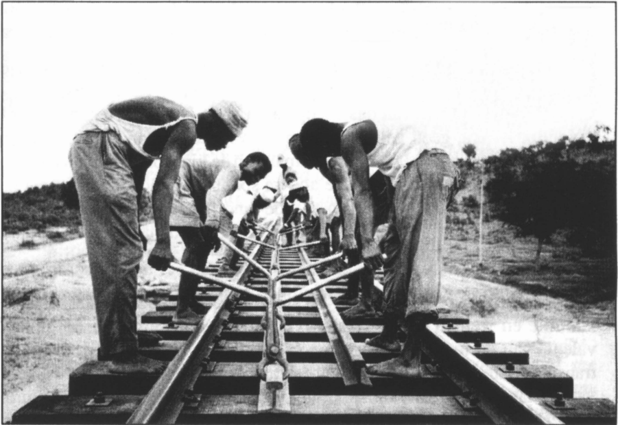
De aanleg van een spoorweg in Nigeria in 1961. Foto: J. Moss (Wereldbank)
